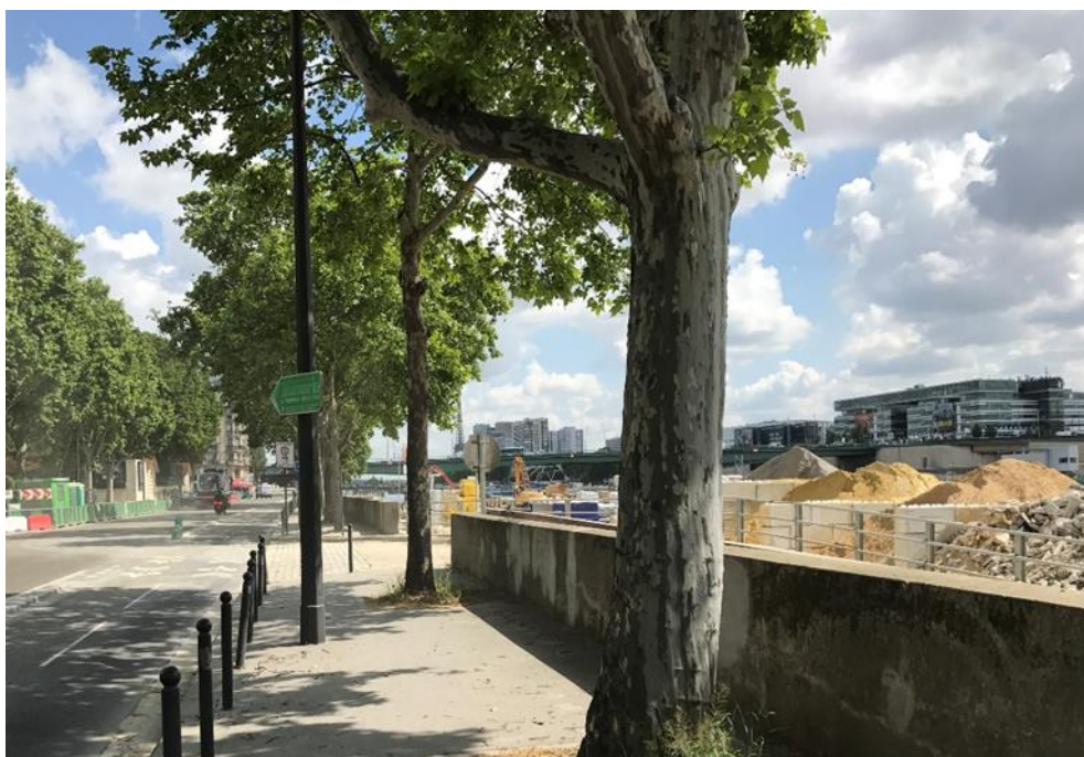
Figure 2 : Illustration des matériaux stockés en vrac au Port du Point du Jour
