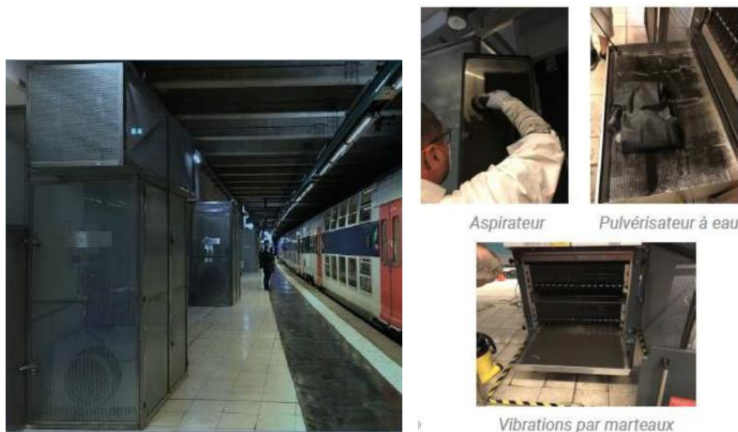
Figure 3– Systèmes de dépollution installés en gare d'Avenue Foch, RER et exemples de différents systèmes de récupération de particules mis en œuvre par AIR LIQUIDE.
